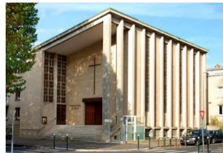
© Eglise réformée unie de France
